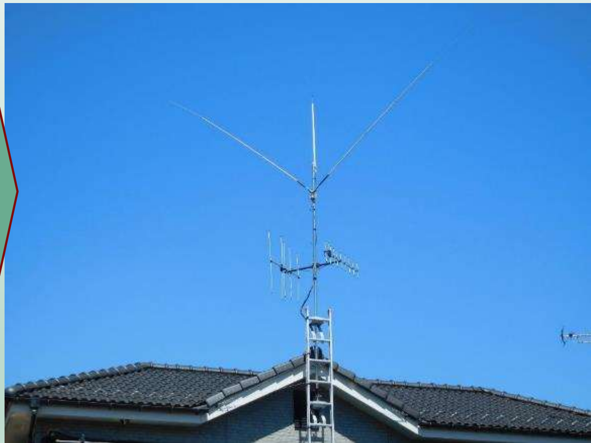
変更後のアンテナ設備: 7MHz~430MHz
